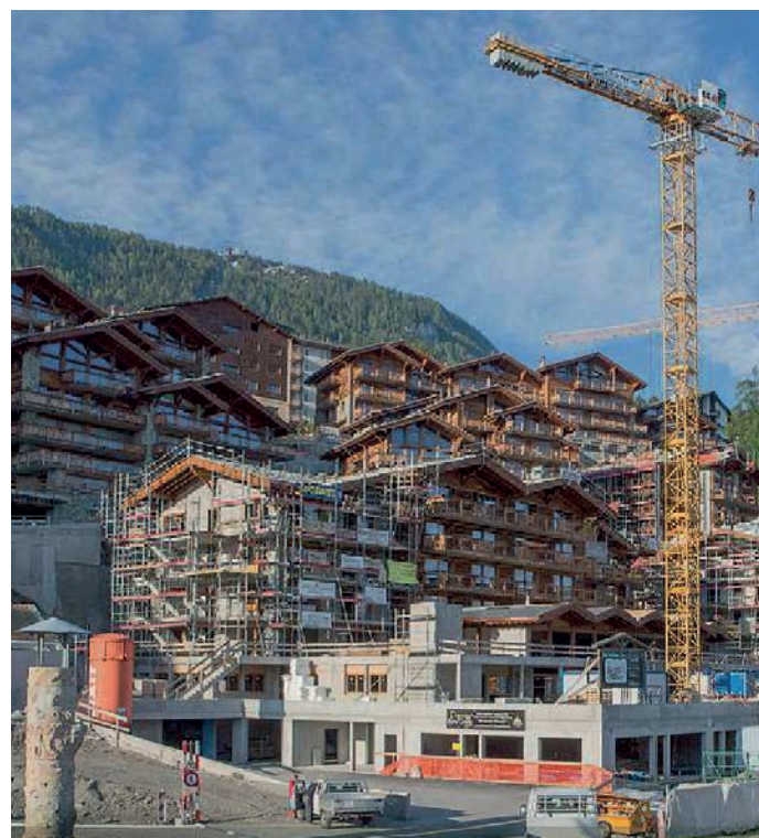
Le chantier de "Mer de Glace"
