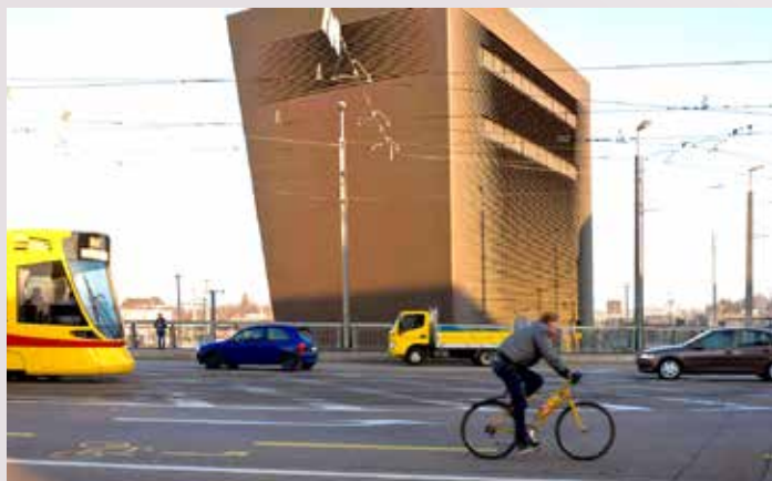
Herzog &amp; de Meuron - Poste d'aiguillage
