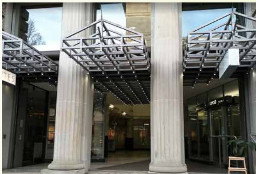
Galerie von Vertes à la Bahnhofstrasse
